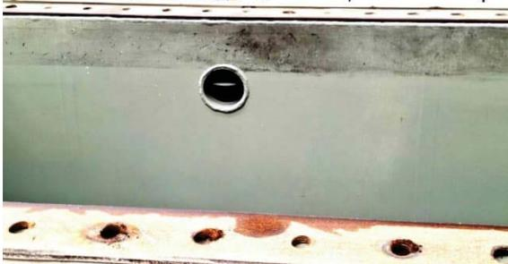
**Bild 13:** Ölstands Markierungen im Kessel
