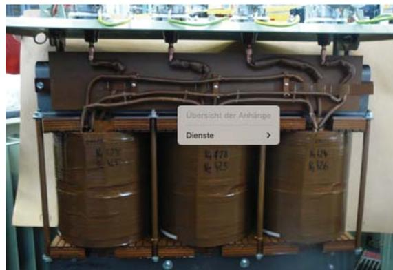
**Bild 13: Das „neue“ Design. Fixierung der Spulen mit axialen Zugstangen und Befestigung, hier ein Muster als Beispiel**
