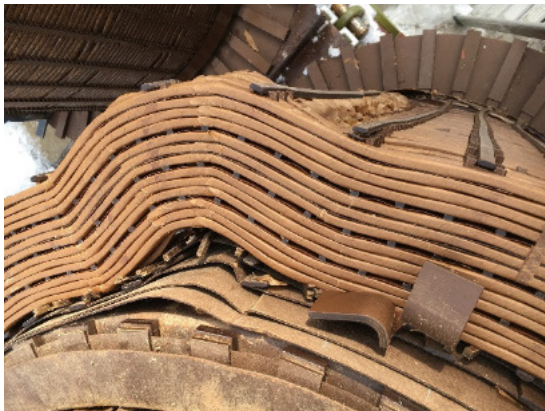
Bild 2: US-Wicklung Phase V mit radialer Deformation (Free buckling)
